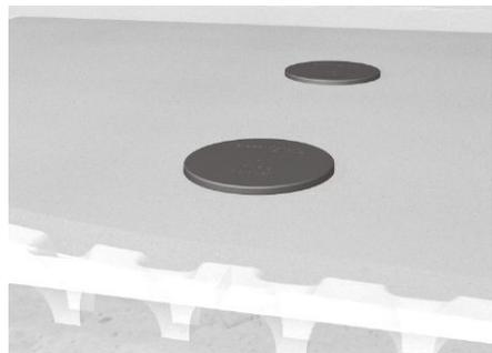
Estrich wird gegossen und die Muldenstruktur des Hohlraumbodens wird verfüllt.
